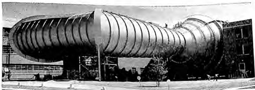
N. A. C. A. 19-FOOT PRESSURE WIND TUNNEL
